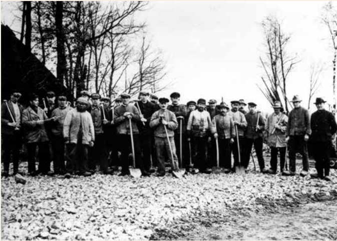
Die so gewonnene Packlage wurde von Hand in die zukünftige Straße eingebaut.
